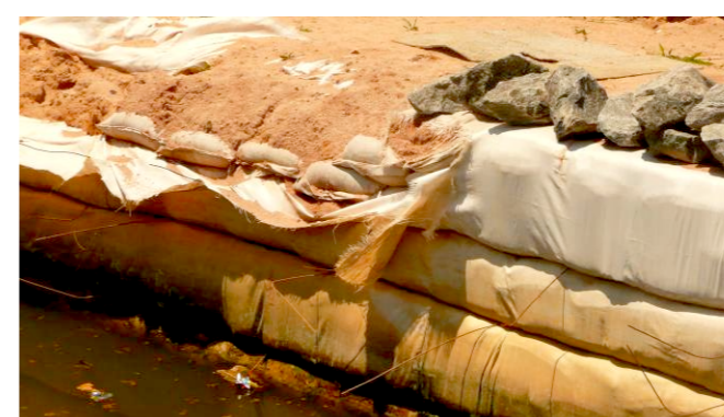
Solo envelopado – presença de geotêxteis no processo.
