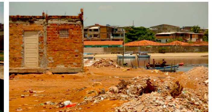
Ponta extrema de Alagados VI – construção da pista.
