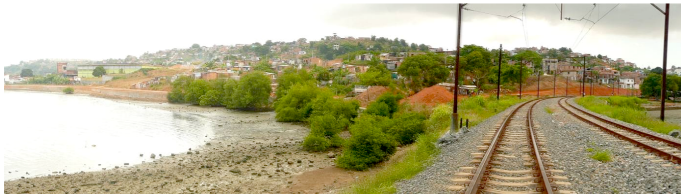
Visão a partir da cabeceira da ponte ferroviária.
