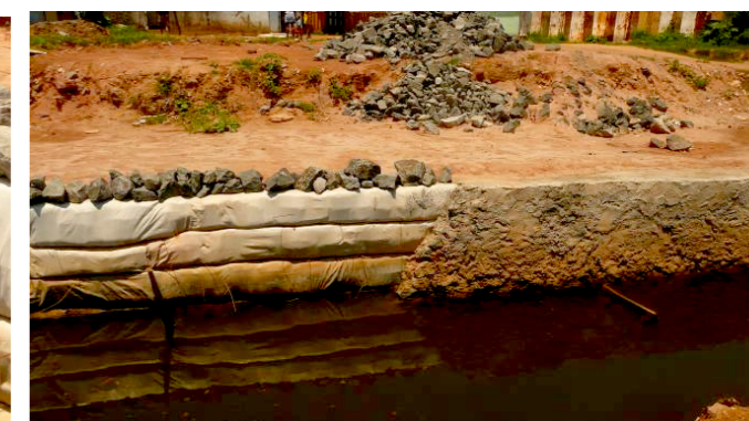
Contenção para a pista de borda – Alagados III e IV.
