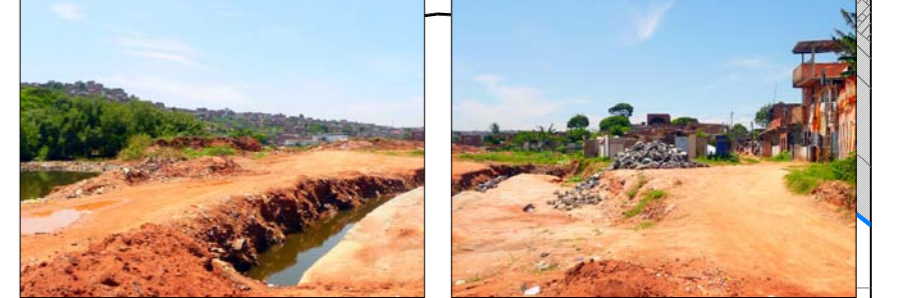
TRECHO EM OBRA. PROGRAMA HABITAR BRASIL - BID
