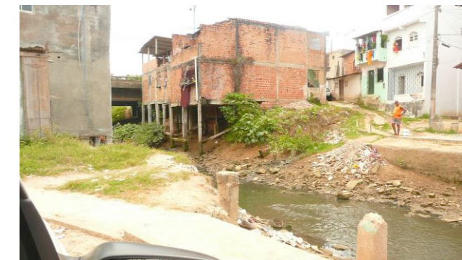
Invasões na borda do rio dificultam a acessibilidade.
