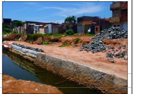
SISTEMA DE CONTENÇÃO UTILIZADO - SOLO ENVELOPADO COM MANTA GEOTÉXTIL.
