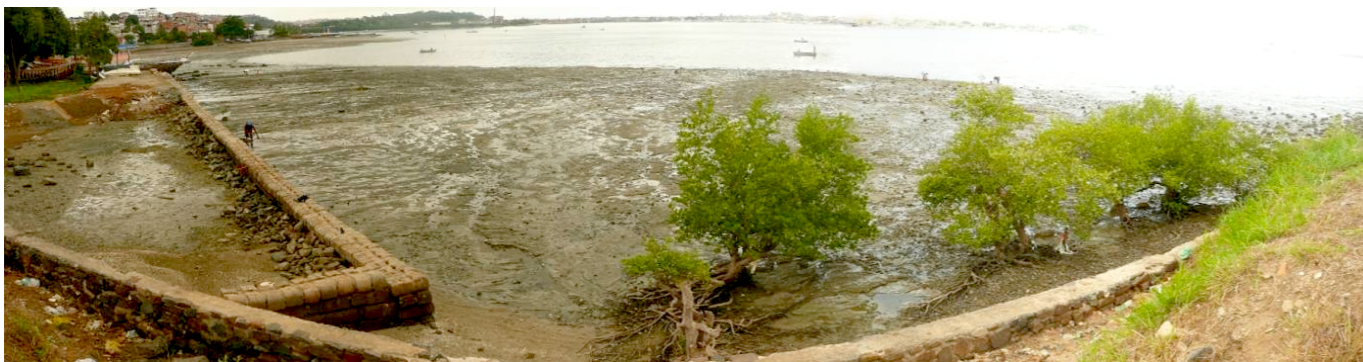
Estaleiro no final do Lobato – contenção com pré-moldados da linha férrea.
