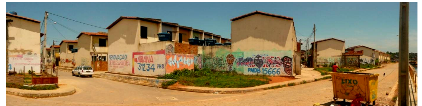
Alagados IV e V – Unidade Habitacional Village – Padrão CONDER
