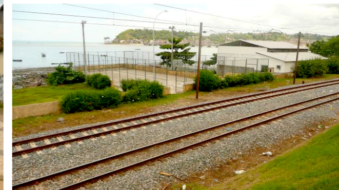
Estaleiro construído segregado pela via férrea.
