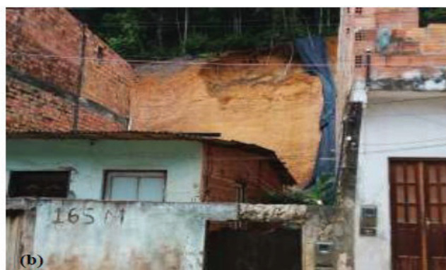
Fig. 7.23: (a) Talude de corte na base da encosta, 06-Beira Dique (557257mE/8571265mN). (b) Cicatriz de deslizamento em talude de corte na base da encosta, 08-Bolandeira (561891mE/8566723mN).
