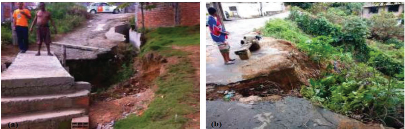
Fig. 7.27: (a) Solapamento de acesso em resposta a evolução de processo erosivo provocado por escoamento concentrado de águas pluviais, 10-Bosque Real (561371mE/85711493mN). (b) Feição erosiva linear provocada por ausência no sistema de drenagem, 10-Bosque Real (561418mE/8571622mN).
