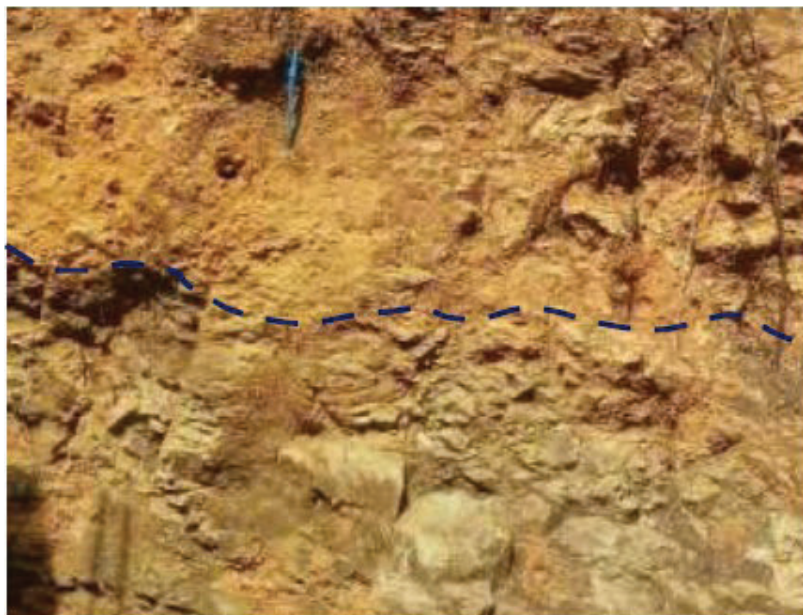
Fig. 7.20: Detalhe do embasamento, exibindo contato rocha sã/rocha alterada, 30-Vila Tiradentes (557122mE/8570078mN).
