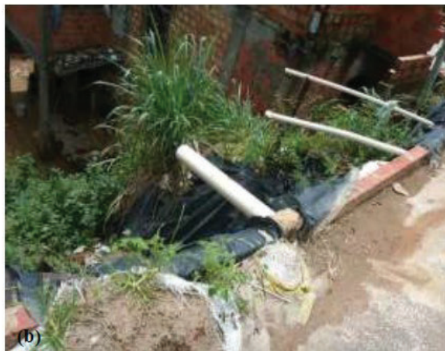
Fig. 7.28: (a) Lançamento de esgoto na encosta e processo erosivo linear, 28-Vilamar (563794mE / 8571241mN). (b) Lançamento concentrado de águas pluviais no talude, 10-Novo Horizonte I.
