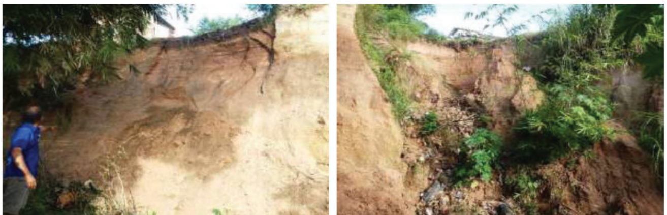
Fig. 7.15: Feição erosiva provocada pelo escoamento superficial concentrado e consequente solapamento de margens e abatimento do substrato. 25-Sabiá (558126mE/8579332mN).
