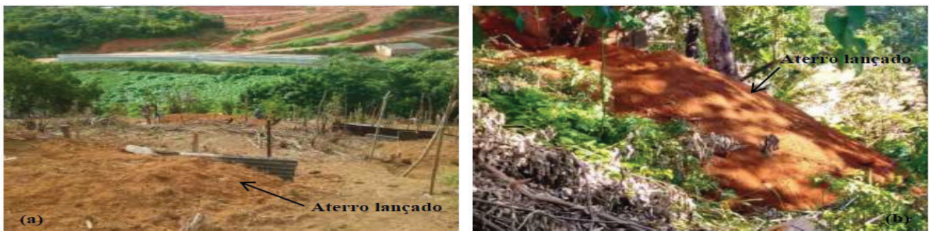
Fig. 7.25: (a) Construção de aterro lançado em encosta invadida pela ocupação em Beira Dique-06 (557291mE/8571270mN). (b) Aterro lançado construído para assentamento de moradia em Calabetão-11 (557788mE/8570001mN)
