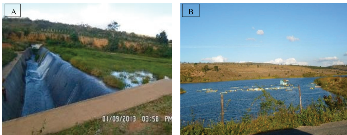
Fig. 9.2 – Barragem de Morrinhos: vertedouro (A) e ponto de captação de água na área alagada a montante do barramento(B) Fonte: PMSB de Poções – BA, 2015.
