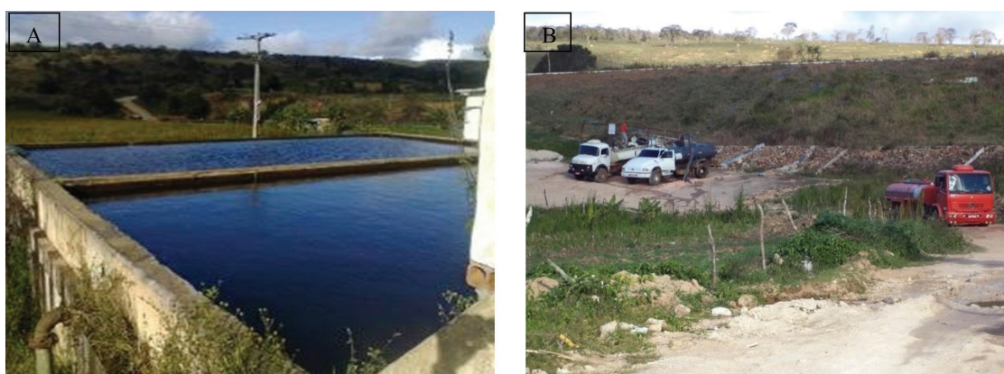
Fig. 9.3 – Reservatório utilizado no abastecimento dos veículos transportadores (carros-pipa) (A) e estacionamento dos veículos (B). Fonte: PMSB de Poções – BA, 2015.
