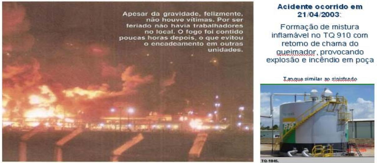
**FIGURA 7 :** Incêndio em Tanque de GLP no Pólo de Atalaia/SE- **Fonte:** Coordenadoria Especial de Defesa Civil de Aracaju/Se, palestra proferida no 5º Fórum de Defesa Civil de Camaçari/Ba por Nailson Melo Santos (**Coordenador**)
