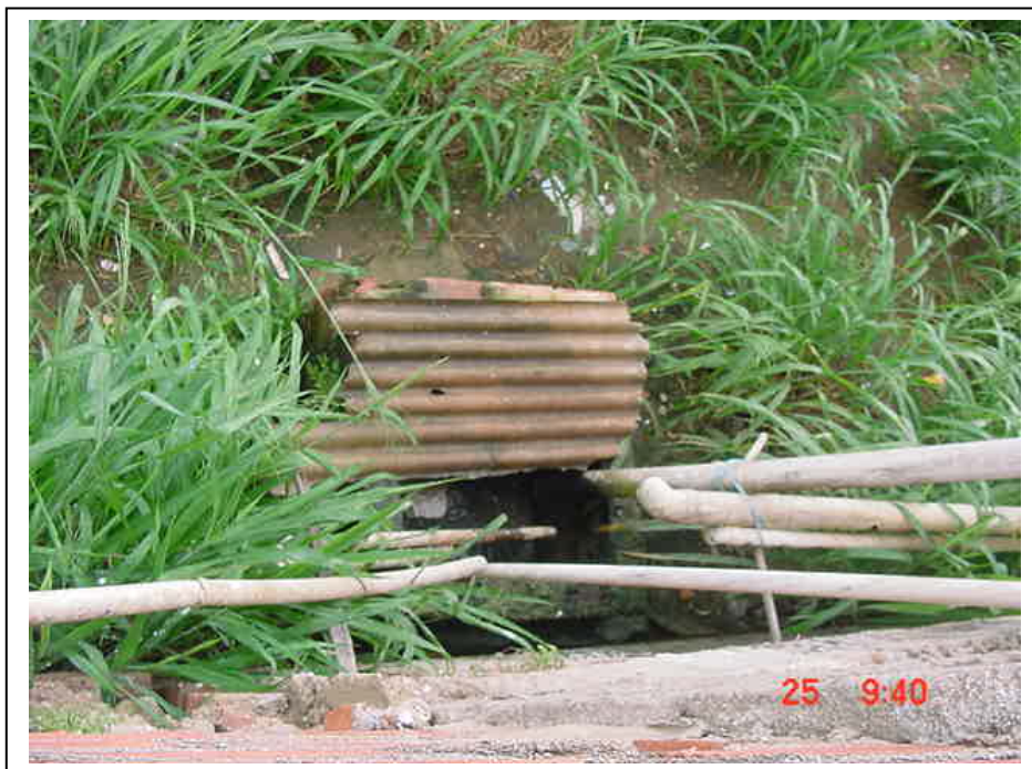
Foto 2 - Fossa rudimentar absorvente - Alto do Bom Viver
