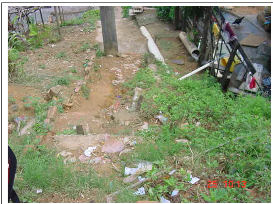
Foto 8 - Soluções de drenagem e deságue de águas residuárias improvisadas pela comunidade - Alto do Bom Viver
