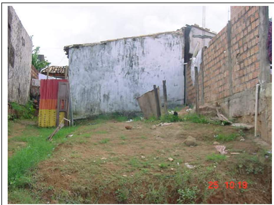
Foto 10 - Área próxima à encosta onde foi removida uma habitação – Rua 10 de agosto - Alto do Bom Viver
