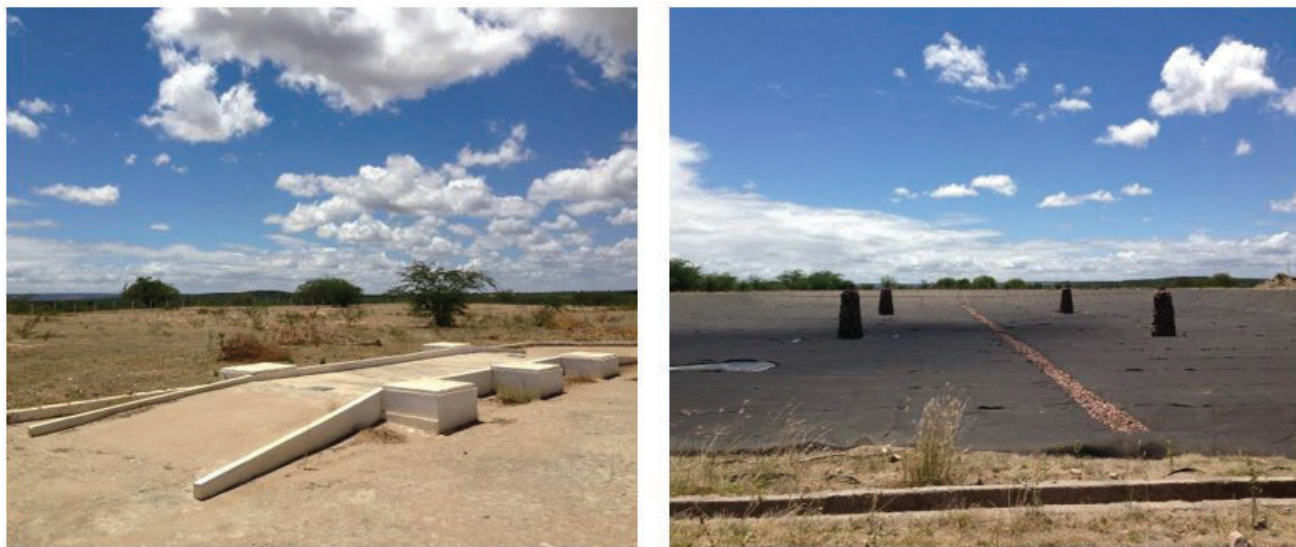
Fig. 4.5 e 4.6 - Instalações do Aterro de Paulo Afonso/BA Fonte: Leva, 2013.
